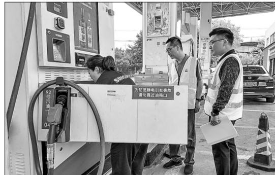
▲6月以来,重庆永川石油围绕“安全生产月”工作部署,大力夯实安全生产基础工作,通过组织员工开展隐患排查、应急演练等,有效筑牢安全生产防线。图为检查人员对加油机内部进行安全检查。黄平华 摄
