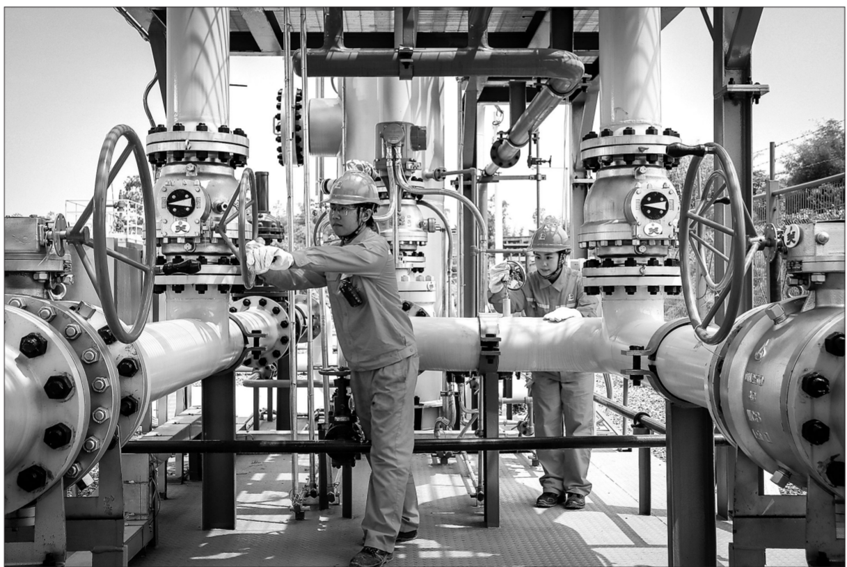
入汛以来,西南油气分公司紧扣“安全生产月”活动部署,实行生产井站驻点巡检,采用“听、看、测、记”四步法排查关键设备隐患,通过智能巡检终端实时上传运行数据,人机联动筑牢安全防线。图为近日员工在永川页岩气田永页37号平台核查天然气生产数据。 管圆圆 摄 展晨文
