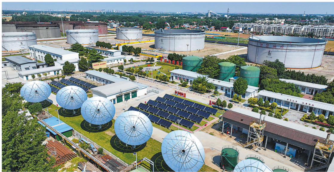
中原油田柳屯中心处理站率先集成“光伏+余热+光热+储热”技术,年节约天然气超100万立方米、减排二氧化碳2000余吨,光伏发电占比约31%,形成多能互补的绿色供能格局。 别墅 摄 杨敬文
