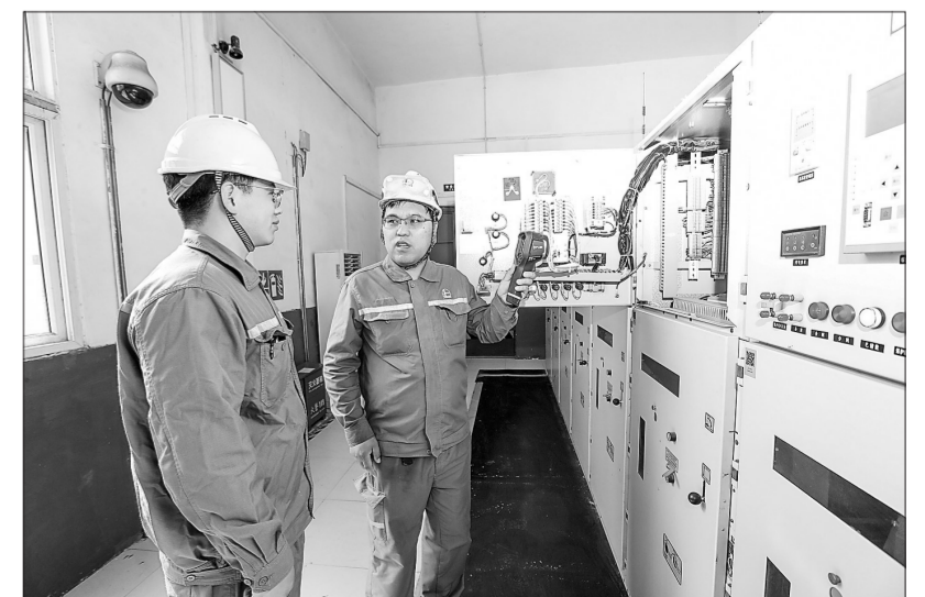
日前,天津石化全面启动暑期供电专项保障工作,运用红外测温等专业技
