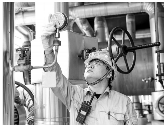
▲金陵石化以安全生产月为契机,聚焦工艺平稳运行和设备完整性管理,持续加强现场巡检,仔细核对关键仪表参数,全面排查风险隐患,保障装置安全平稳运行。图为6月8日,对二甲苯装置员工在现场检查压力表参数。张兴摄 陈伟文
