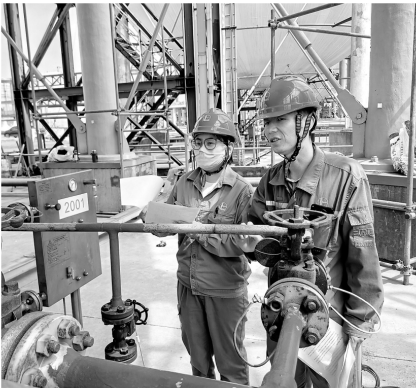
▲进入6月以来,安庆石化深入排查整治隐患风险,从严抓实夏季“四防”工作。该公司储运部组织各区域专业管理人员对罐区盲板管理、喷淋降温设施、储罐安全附件及管线放压情况开展隐患排查,进一步夯实安全生产基础。图为区域专业管理人员在液化气罐区检查盲板。郝书敬摄
