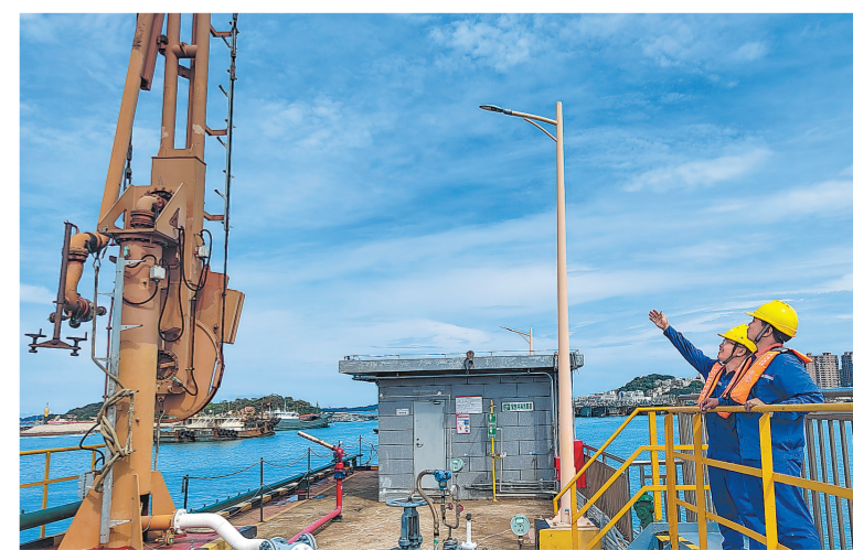
福建石油以开展“安全生产月”活动为抓手,把安全责任压实到基层末梢,全面发动员工开展各类风险隐患排查整治,持续提升企业本质安全水平。图为6月8日漳州石油铜陵油库员工排查输油臂安全隐患。
