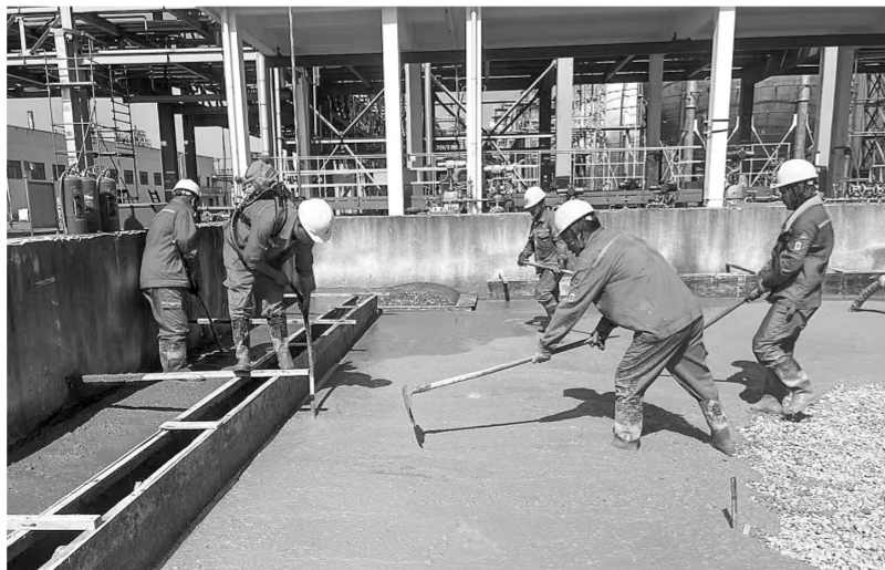
项目施工人员进行混凝土面层浇筑作业。王超 摄
