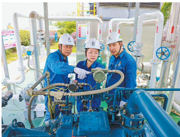
安徽石油合肥油库依托智能管控手段,扎实开展油气回收专项安全检查,通过在线监测系统,将装置流量、压力、温度等关键参数实时传至中控室,进一步加强设备监管,守牢安全防线。图为6月5日油库员工对油气回收装置进行隐患排查。
