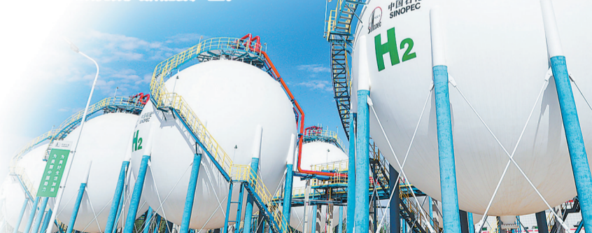
新星新能源公司新疆库车绿氢示范项目。
