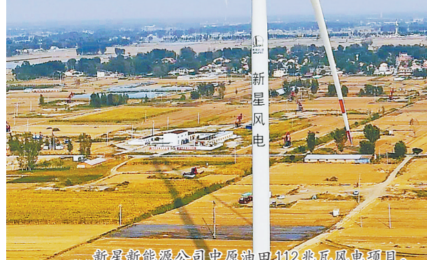
新星新能源公司中原油田112兆瓦风电项目。
