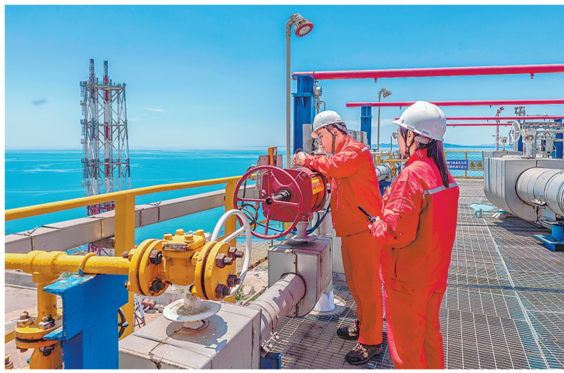
天然气分公司青岛LNG接收站加密设备巡检频次,对站内可燃气体检测设备、连锁控制系统等关键装置开展自主检定校验,及时消除各类隐患,全力保障生产装置平稳可靠运行,以精细化运维筑牢安全生产防线。图为6月2日员工在储罐顶部检修设备。刘晶晶摄
