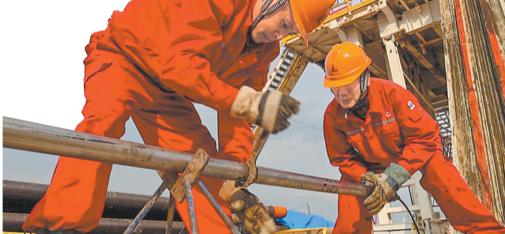
经纬公司胜利测井公司员工正在进行过钻头存储式测井施工前的仪器连接工作。 李战勇 摄
