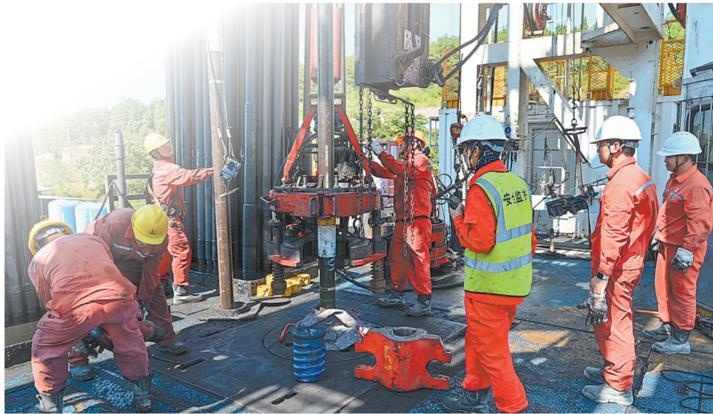
江汉油田过钻头存储式测井作业现场。
