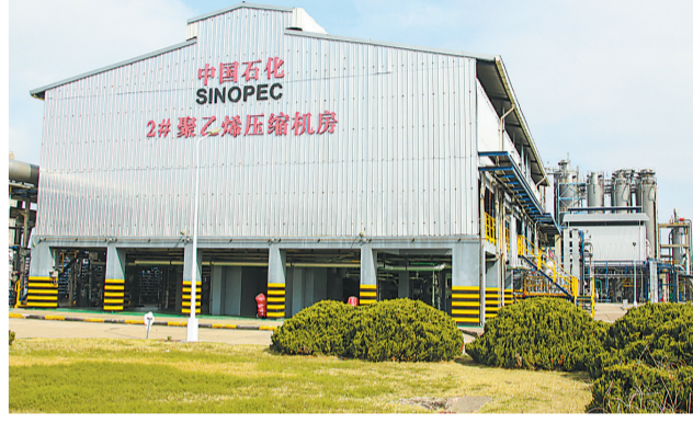
上海石化2号聚乙烯压缩机房。
