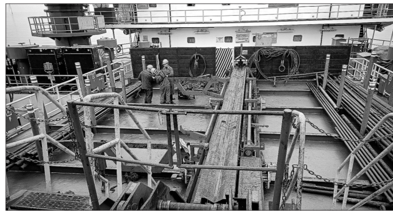
胜利石油工程公司井下作业公司试油一队队员调试安装液压举升腿,为平移猫道机做准备。
