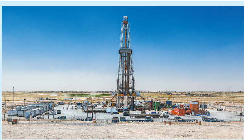
图为伊拉克油气作业现场。视觉中国 供图
