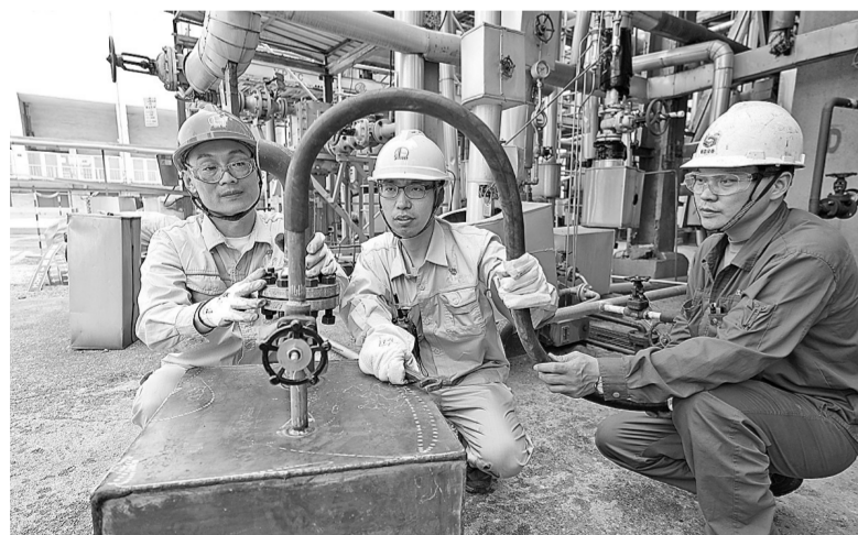
为推进行工装置绿色检修,扬子石化芳烃部员工积极开展“五小”活动,针对低点导淋口、法兰连接处等关键易泄漏部位,自制活性炭吸附盒。这些吸附盒能够在装置检修吹扫过程中,有效吸附挥发性有害物质,防止异味扩散。图为5月14日,员工利用吸附盒进行有害物质拦截调试。 李树鹏 摄 鲁芸宇 裴军文
