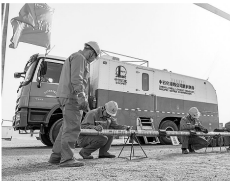
在新疆“深地工程”油气井施工中,经纬公司胜利测井公司施工人员严把作业质量关,在测井仪器下井前仔细检查通断、绝缘情况,确保安全生产。
