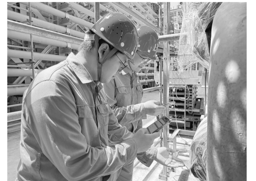
十建公司浙江舟山高压聚乙烯装置项目部质量检查人员对施工全流程动态把控,实现施工质量隐患早排查、质量问题快整改。
