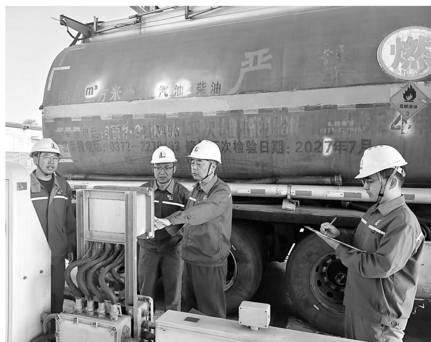
日前,河南中原石油全面启动夏季安全生产隐患排查整治行动,并重点对核心收发油设备展开预防性维修保养工作,切实保障油库安全平稳运行。图为5月6日,安全检查人员在油库对发油设备进行安全检查。
