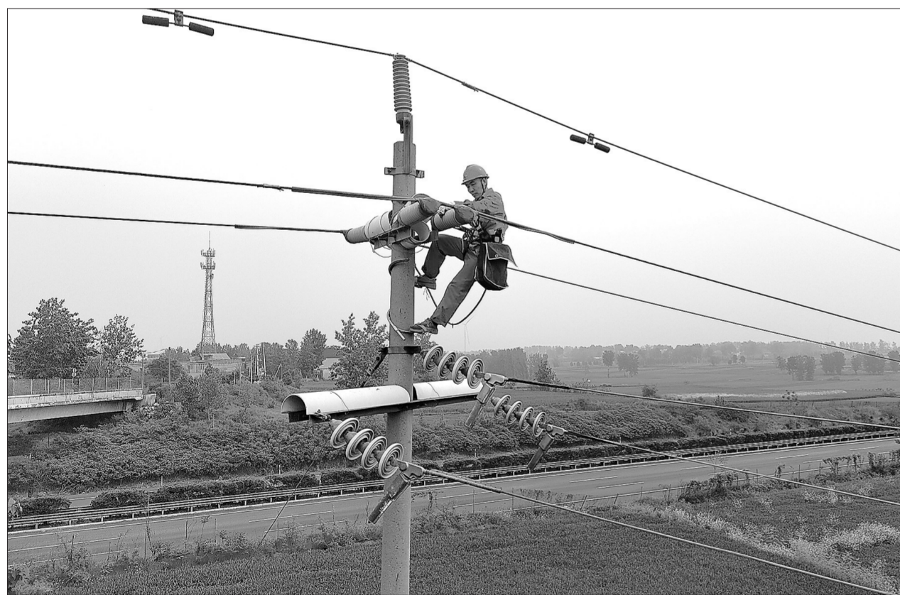
河南油田完成电网检修进一步保障用电安全
