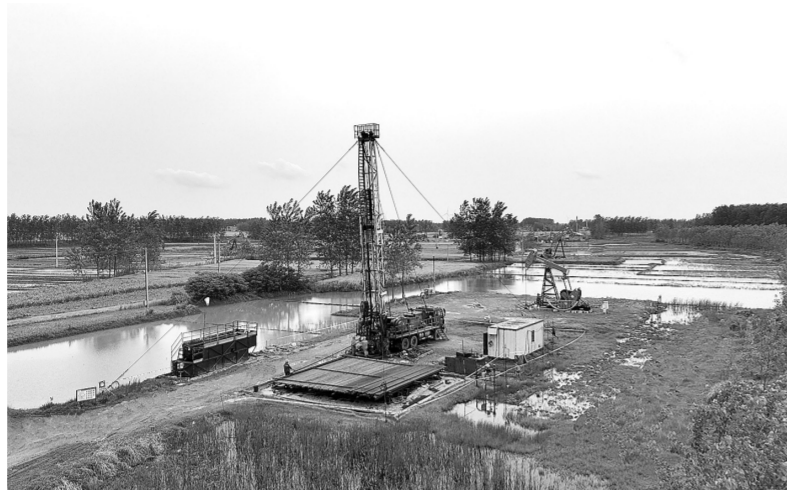
江汉油田71钻-1-6-10井作业现场。 李东勇 摄
