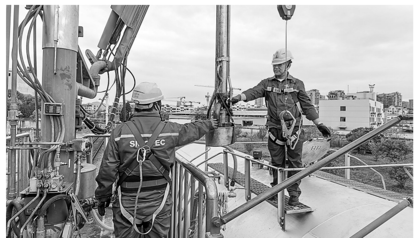
莲都油库卸油员使用旋转式防坠装置在铁路栈桥上卸油。 李建霞 摄
