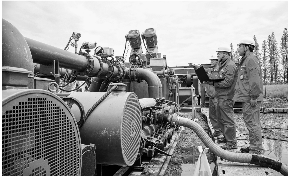
华东油气成功投运电动压驱混砂橇
