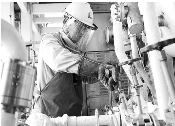
重庆石油聚焦作业人员劳动防护用品规范佩戴,开展全覆盖专项检查整治,从强化现场职业健康管理。图为4月23日,涪陵LNG工厂充装人员规范佩戴个体防护用品进行槽车连接作业。 陈德勇 摄 李森芸 文
