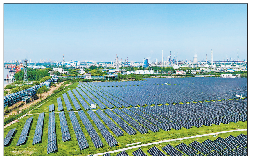
截至4月29日,扬子石化光伏发电项目自2023年投运以来累计发电突破8000万千瓦时。项目采用“自发自用,余电上网”运营模式,绿电就地消纳利用率高,可大幅减少二氧化碳排放。图为光伏发电项目现场。李树鹏 摄 宋启欣 文
