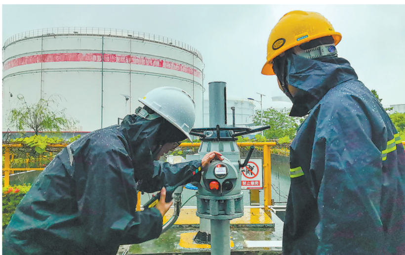
销售华南组织员工全面检查排水系统运行、应急物资储备等情况,提前对雨水沟开展清淤疏堵作业,加固防汛沙袋。图为4月27日销售华南茂名区域中心员工检查清污分流系统设备。
