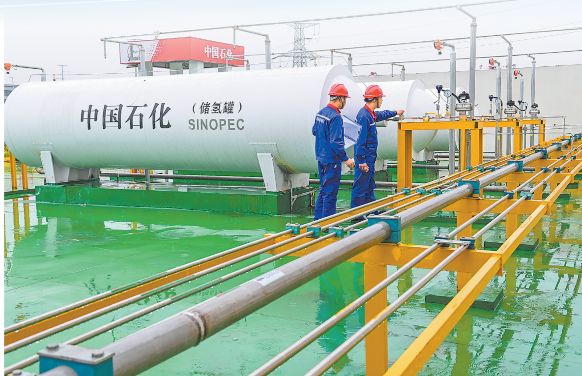
河南石油新乡南二环路氢电合建站员工巡检加氢设备。 薛宝泉摄
