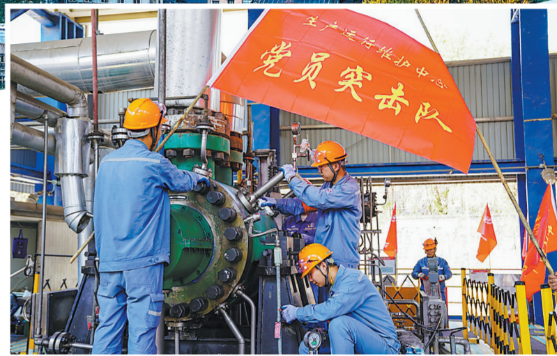
检修现场,党员突击队冲锋在前,聚力攻关。
