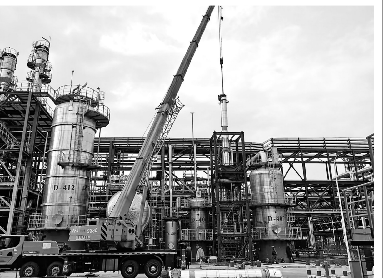
海南炼化丁二烯抽提装置残液水洗项目成功投用
