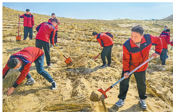
在腾格里沙漠西南边缘,甘肃张武(共享)石油积极开展压沙固沙活动,防沙止漠、保护生态。图为员工在荒滩上铺设草方格。 徐晓东 刘晓娜 摄影报道
