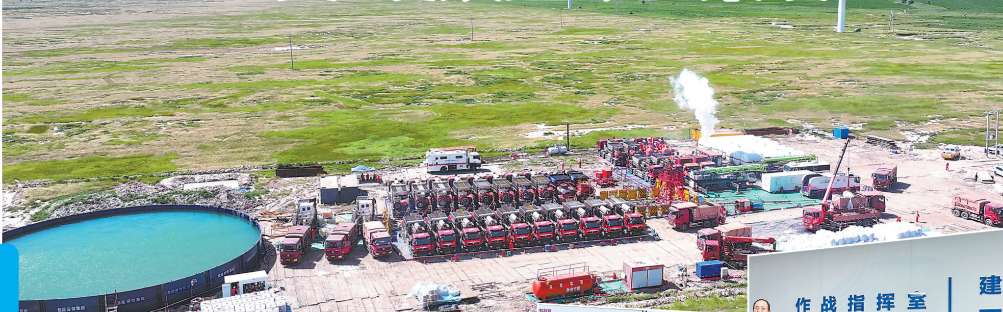
东北油气龙凤山气田大型压裂施工现场。张凯摄
