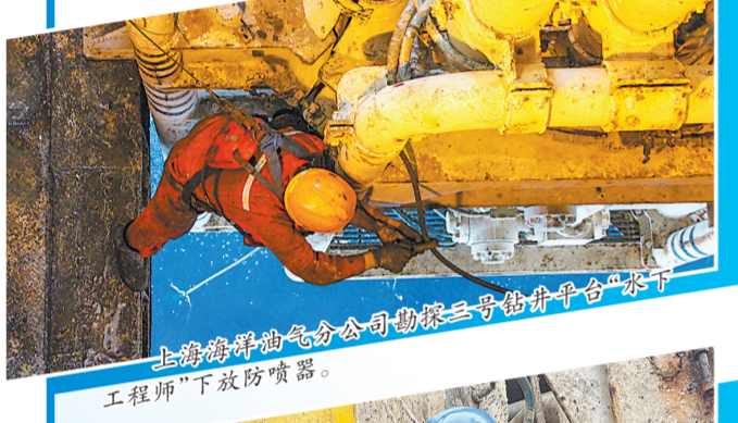
上海海洋油气分公司勘探三号钻井平台员工进行防喷器移位作业。
