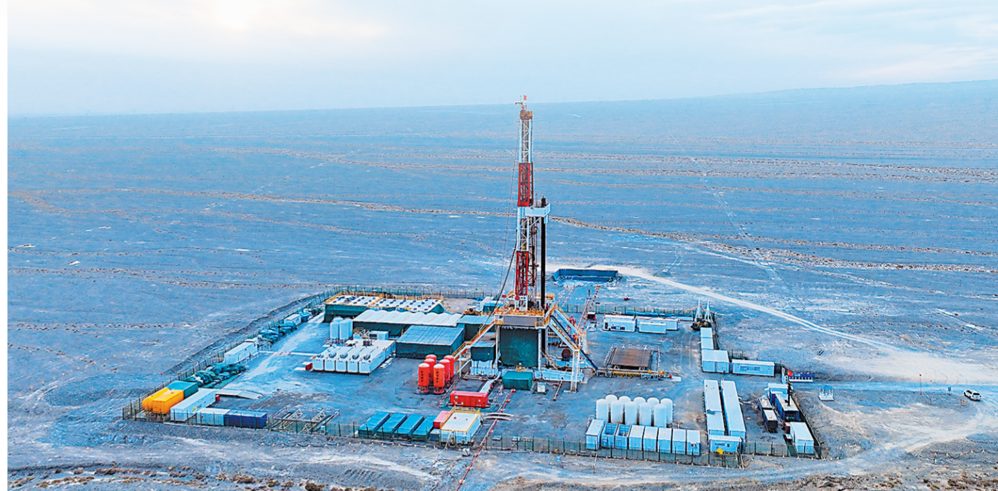
集团公司重点探井西北油田库深1井。
