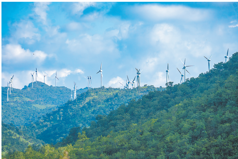
图为印度卡纳塔克邦风电项目。视觉中国 供图
