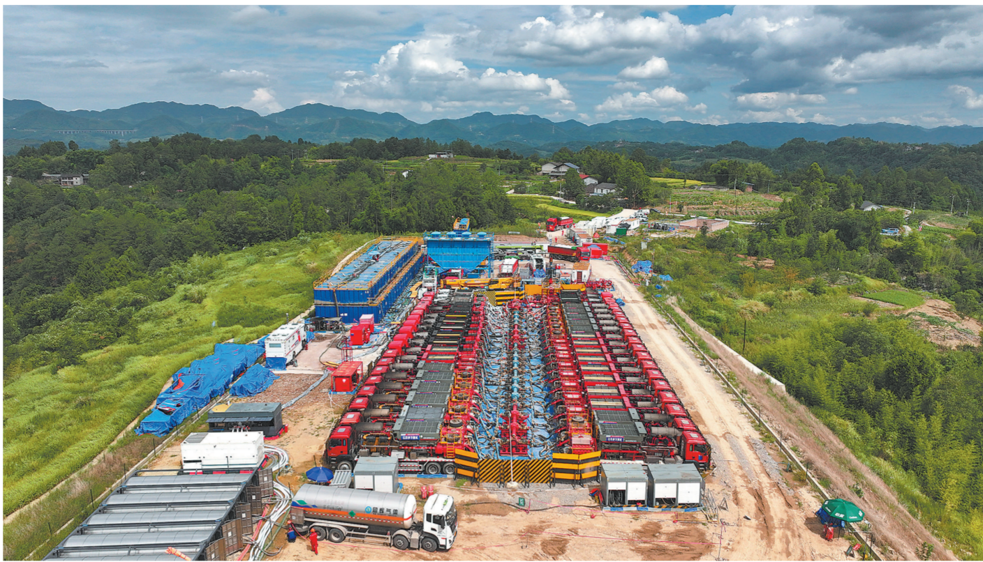
江汉油田复兴区块兴页L186-6-1HF井压裂现场。
