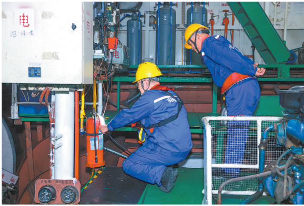
销售华东员工检查船舶机舱内消防设备保养情况。
