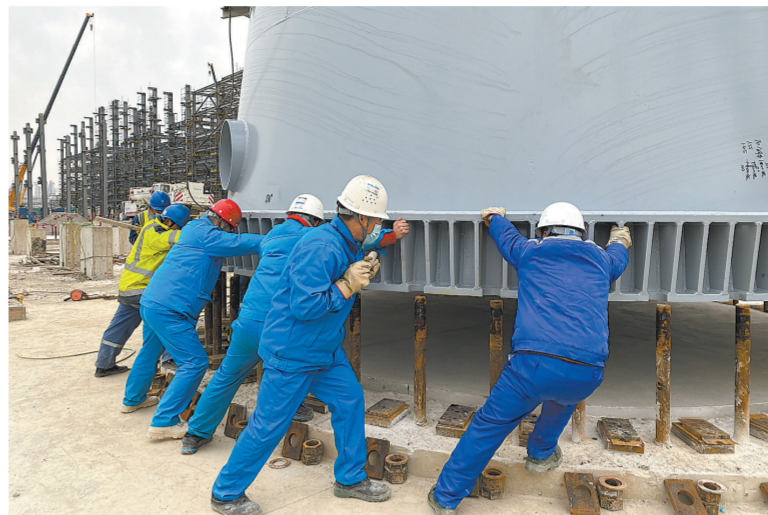
第一萃取塔吊装就位。
