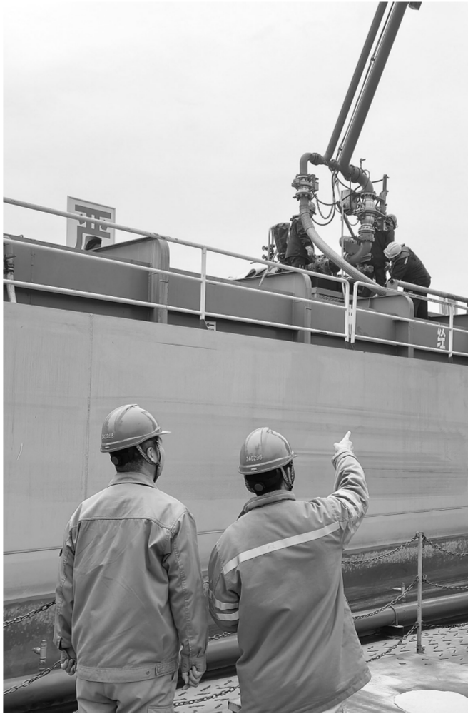
春节假期,安庆石化严格执行干部员工值班带班制度,值班人员深入罐区、装卸站、危化品码头等关键区域,细致开展现场巡检与隐患排查,及时消除潜在风险,全力保障春节期间储运生产安全平稳运行。图为近日员工检查装置运行情况。郝书敬 摄
