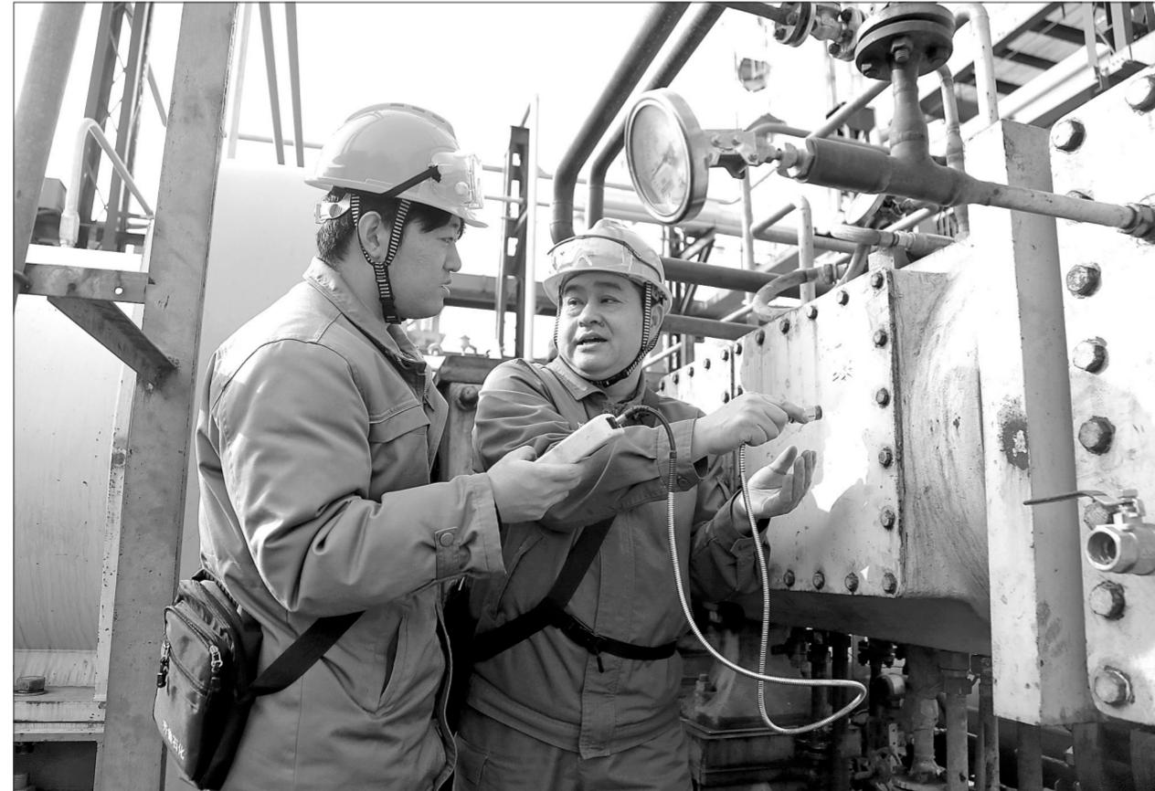
齐鲁石化持续开展设备专业导师带徒活动,通过系统化传授、指导与训练,实现技能、工作作风的有效传承,切实提升青工工作能力与专业素养。图为2月5日,齐鲁石化首席技师刘延波(右)向徒弟、远维中心二化远维车间检修维修二班青工卢冠龙介绍闪蒸气压缩机测振方法。
