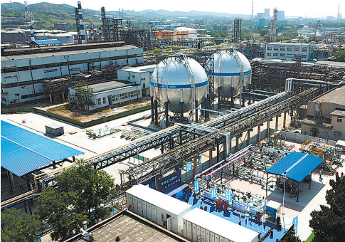
图为公司承建的我国首条百公里、百万吨、超临界压力二氧化碳输送管道——齐鲁石化—胜利油田CCUS项目二氧化碳输送管道。
