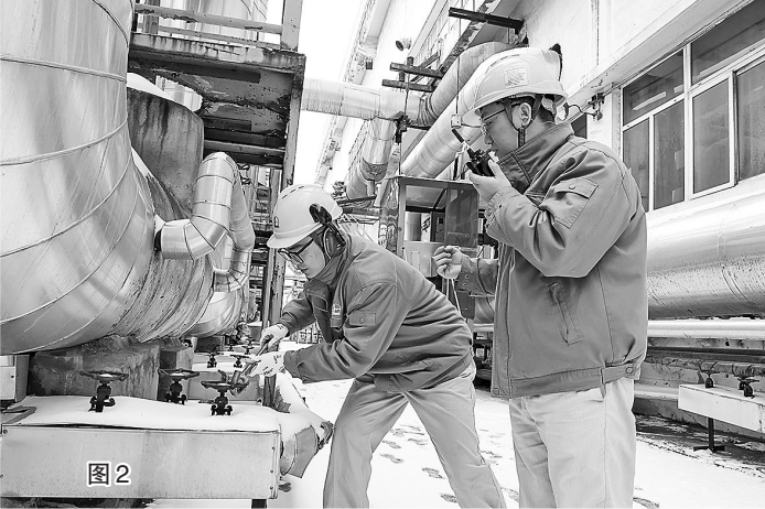
图1:胜利石油工程渤海钻井总公司压实钻台、泵房、网电箱和管汇等关键区域冬防保温职责,加强设备设施的防冻防凝监测与维护,做到识别风险、应对措施和应急保障三到位,确保钻井施工安全平稳运行。图为1月21日,在胜利油田义104-平9井施工现场,50689钻井队员工用高温蒸汽对管汇阀门进行加热,防止管汇和阀门出现冻结。 王国章 摄 王 福 文
