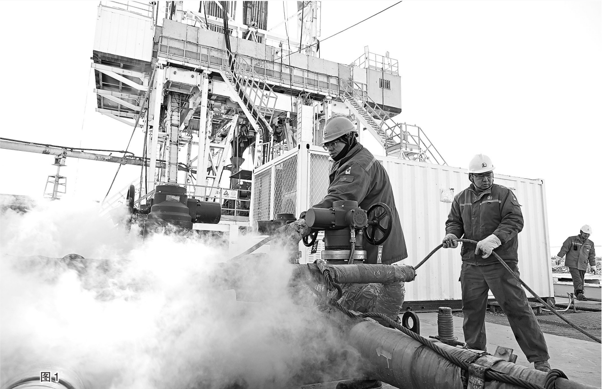
图1:胜利石油工程渤海钻井总公司压实钻台、泵房、网电箱和管汇等关键区域冬防保温职责,加强设备设施的防冻防凝监测与维护,做到识别风险、应对措施和应急保障三到位,确保钻井施工安全平稳运行。图为1月21日,在胜利油田义104-平9井施工现场,50689钻井队员工用高温蒸汽对管汇阀门进行加热,防止管汇和阀门出现冻结。 王国章 摄 王 福 文
