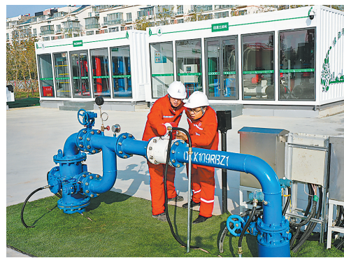
胜利油田技术人员在辛109热源井口进行压力监测。
