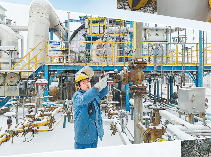
▲入冬以来,宁夏能化将防冻防凝作为核心环节,针对冬季装置运行特点,从工艺、设备、安全、电气、仪表等多方面系统辨识风险,并制定针对性防范措施,保障装置安稳过冬。图为甲醇运行部净合二班员工排查装置隐患。 丁 繁 摄
