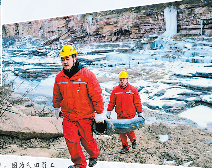
能源通过管网输送至千家万户。图为气田员工顶风冒寒,在焊接完的输气管线现场,整理回收作业余料。 沈志军 摄 张道宏 文
