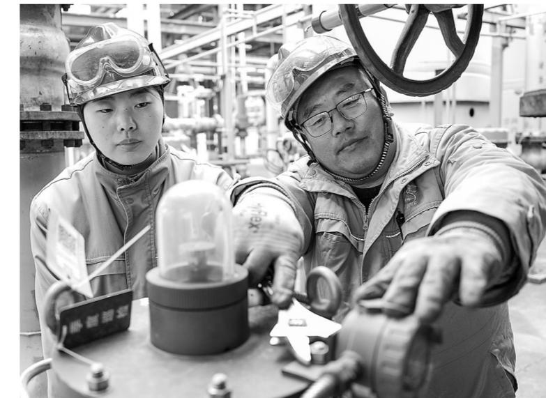
南化公司检维修部仪表分部主任技师叶纲(右)与同事在煤化工部PSA装置现场利用万能安装板固定阀门定位器。
