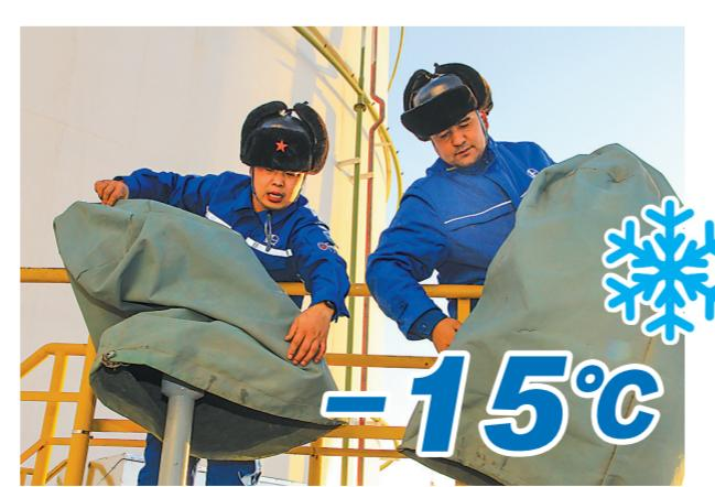
1月14日,新疆伊犁地区气温降至零下15摄氏度。新疆伊犁石油伊宁油库检维修班组员工加密库区关键设备巡检,并对关键阀门实施双重防冻保温作业。他们仔细包裹保温材料、紧固管线,确保储运设备在极端低温下安全稳定运行。
