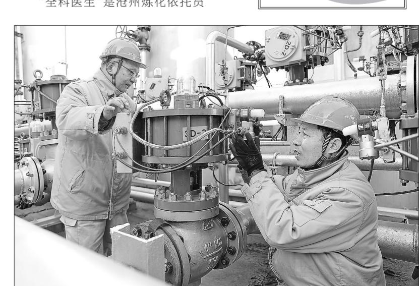
面对低温天气，胜利油田石油化工总厂认真贯彻落实冬季“六防”措施，在轻烃罐区、重油催化裂化装置区、催化重整装置区等安全重点区域开展防冻防凝专项检查，加大监督巡查力度，确保装置安稳过冬。图为近日胜利油田石油化工总厂员工对仪表设备开展防冻防凝专项检查。
