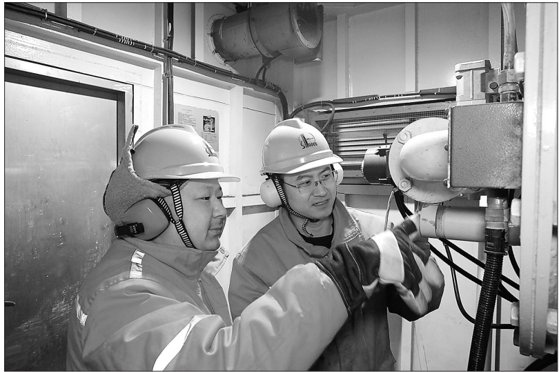
近日,针对海上大风寒潮天气,胜利油田海洋采油厂海上平台落实防寒防冻措施,组织干部员工增加易冻部位和伴热带巡检频次,充分利用自动化监控系统准确掌握加热器、热媒炉等保温设施运行状态,筑牢海上安全生产防线。图为1月11日胜利油田中心三号平台员工巡检热媒炉运行情况。张 灿 摄
