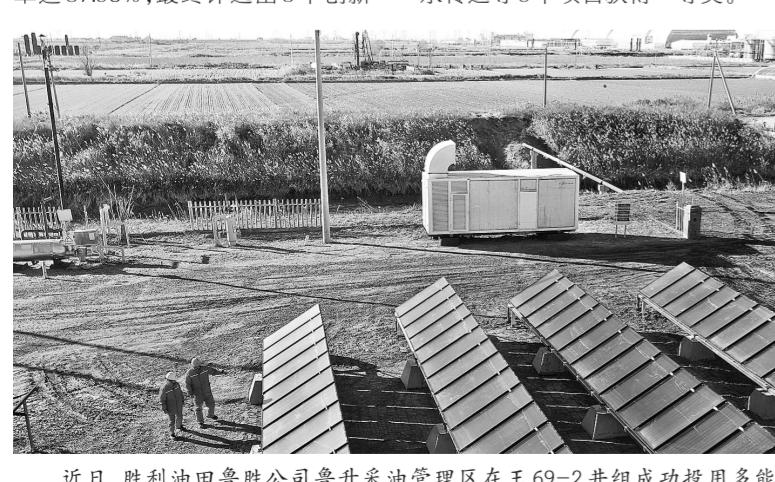
近日,胜利油田鲁胜公司鲁升采油管理区在王69-2井组成功投用多能耦合原油加热装置。该装置的“光热+空气源热泵+相变储能”系统,能够依据实际需求智能切换能源种类,与原先的电加热装置相比,日耗电量从576千瓦时降至174千瓦时,实现了能源智能互补与清洁利用。图为2025年12月25日,员工在现场查看多能耦合加热装置的应用情况。
