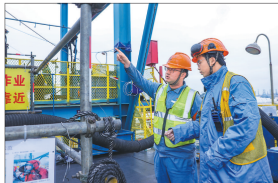
元旦假期,海南炼化干部员工坚守岗位一线,做好生产运行、检修等各项工作,奋力实现新年开门红。图为元旦假期海南炼化渣油加氢装置换剂检修现场。
