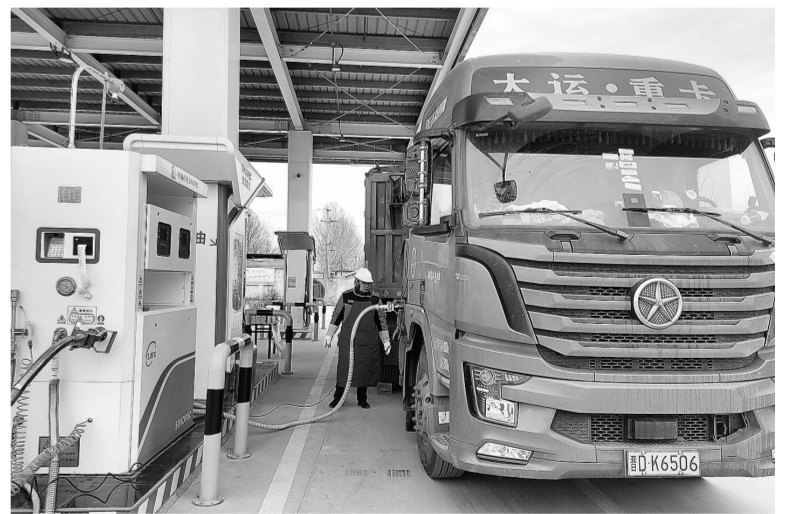
12月23日,山东德州石油首座LNG加气站——禹城17站正式投运。该站配备1座54立方米LNG撬装设备,设一台双枪加气机,可同时为两辆车提供充装服务,为区域内物流运输等行业提供高效环保的能源服务。图为该站员工服务客户。 路 娟 摄
