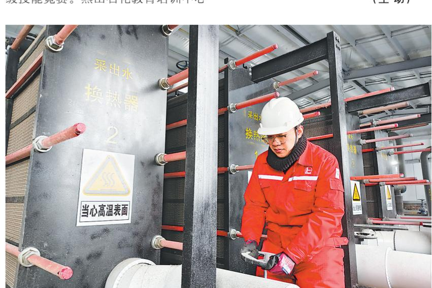
近日,胜利油田春风二号联合站余热利用工程成功投产。该项目充分利用采出液余热,年可替代原煤9449吨,大幅减排二氧化碳。目前,该工程正按350吉焦/日负荷平稳运行,最大日供热量可突破500吉焦。图为工作人员在余热利用工程现场巡检。
