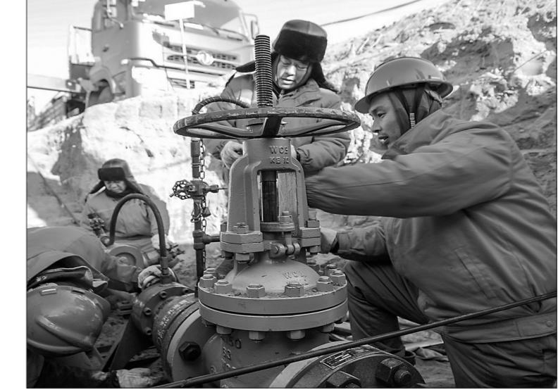
今年以来,华北油气分公司采油气工程服务中心应用不停输带压开孔工艺,在作业中精准把控开孔定位、壁厚检测、焊接固定等关键工序,有效规避传统工艺带来的产量损失,为大牛地气田生产稳定筑牢坚实保障。截至目前,该中心已凭借该工艺顺利完成16井次作业,有效提升作业效率。图为员工进行带压开孔作业。
