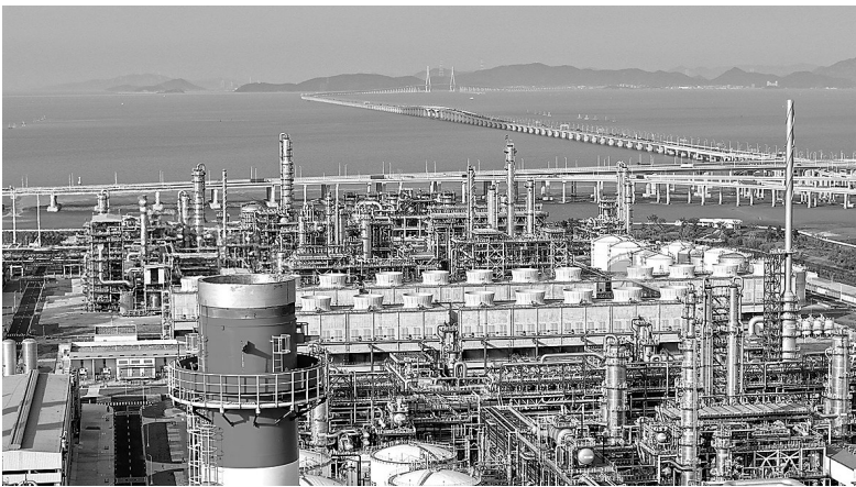
安装消雾模块的镇海基地二期循环水池冷却塔群。本报记者 何雯摄
